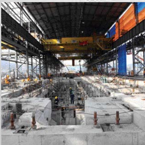
As obras de montagem do novo Laminador de Tiras a Quente da Usina de Cubatão são conduzidas pela Usiminas Mecânica
